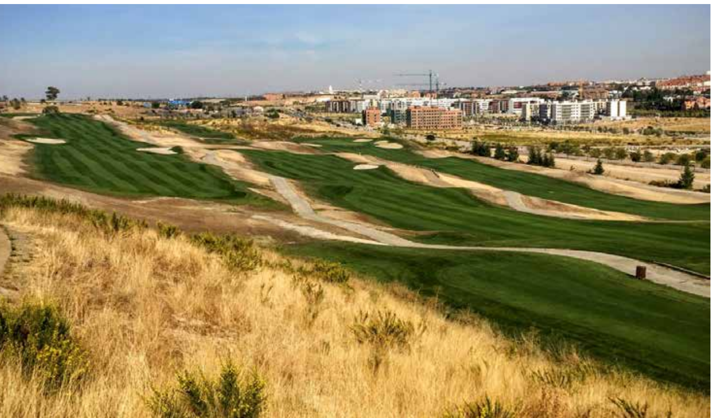
Imagen 12. Resultado final después de la ejecución de la reforma en la que se observa la reducción de la superficie de riego y la buena calidad de las calles.
