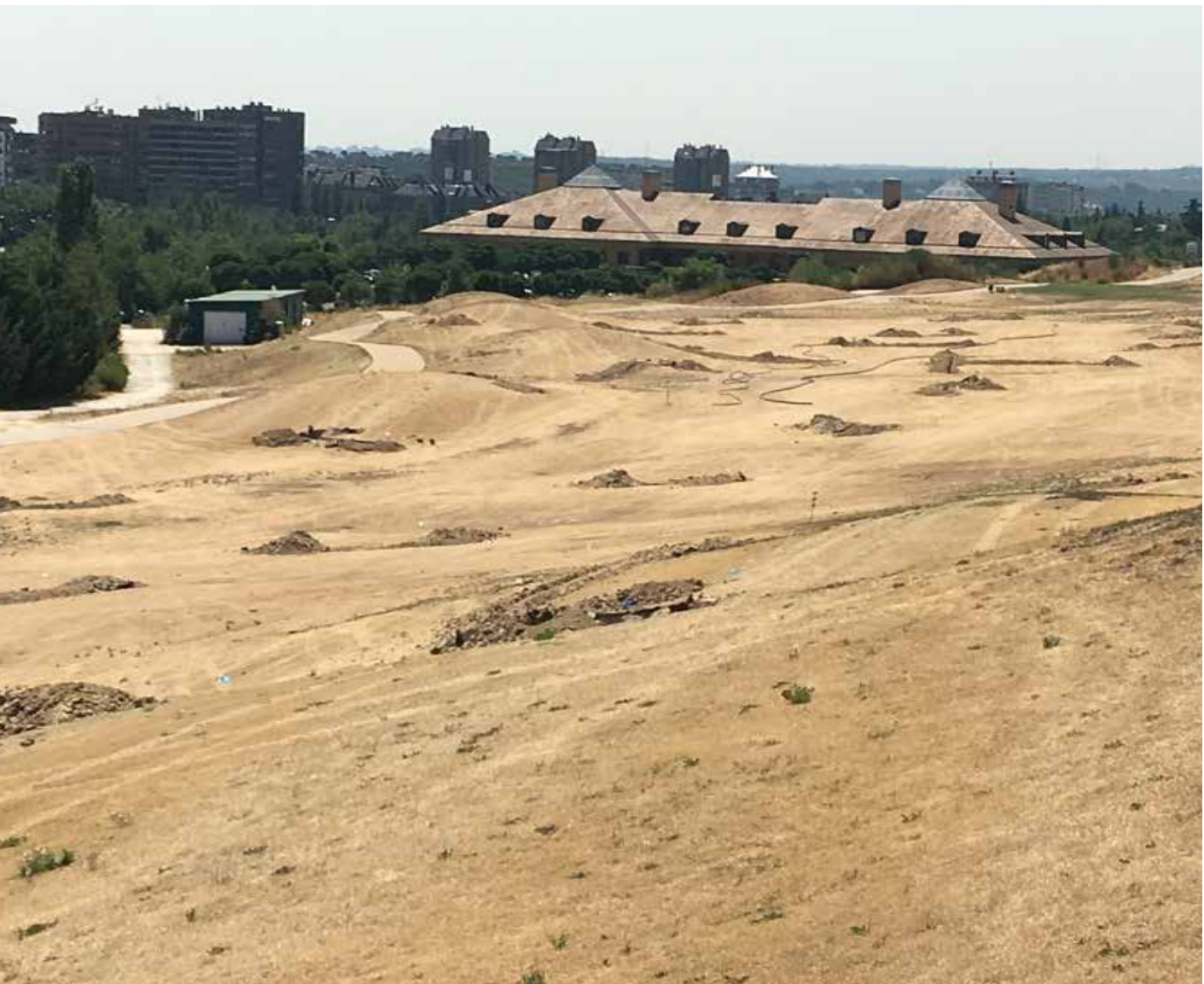
Imagen 10. Fotografía que muestra la apertura de zanjas para la colocación de los nuevos aspersores.
