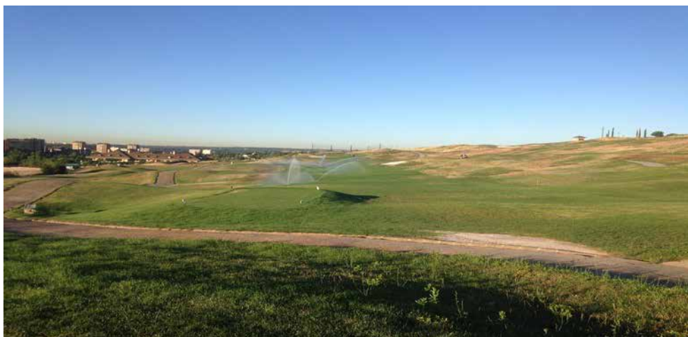
Imagen 4. Zona del campo en la que se observa que no hay un eje de calle.
