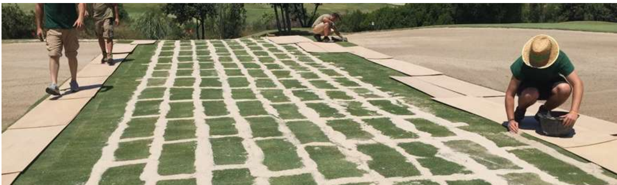
Colocación de los tepes de Bermuda enana.
