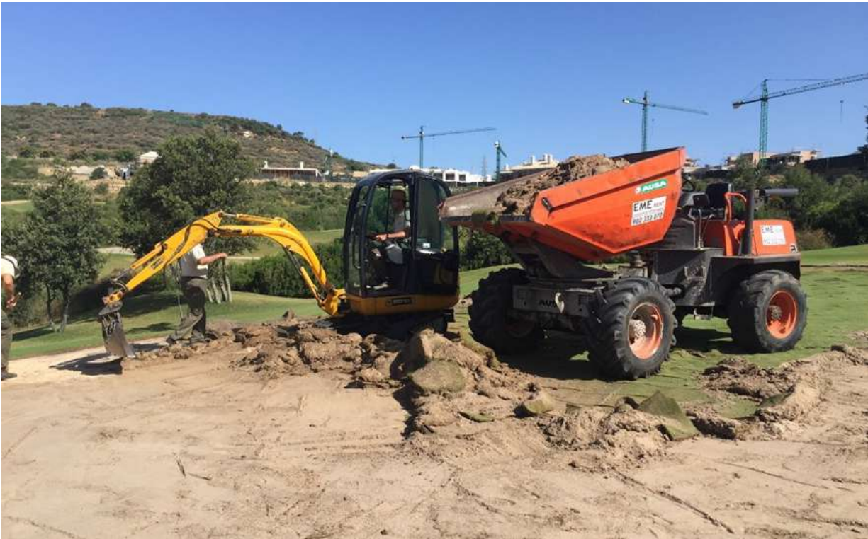
Trabajos de retirada de la capa superficial en un green.
